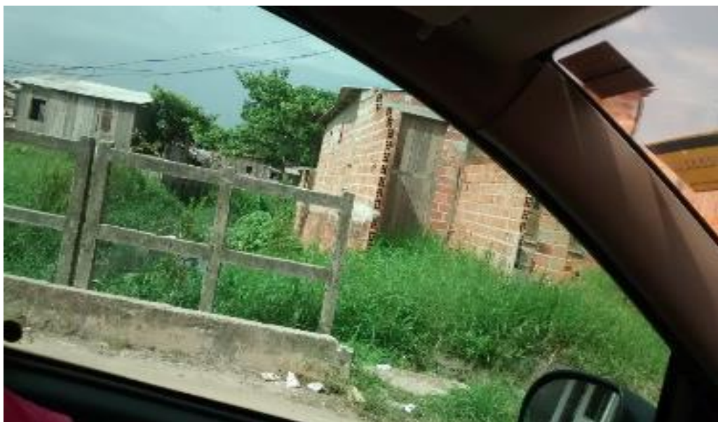
Fig.3. Canal que serve de esgoto no bairro Parque Guajará, 2015
